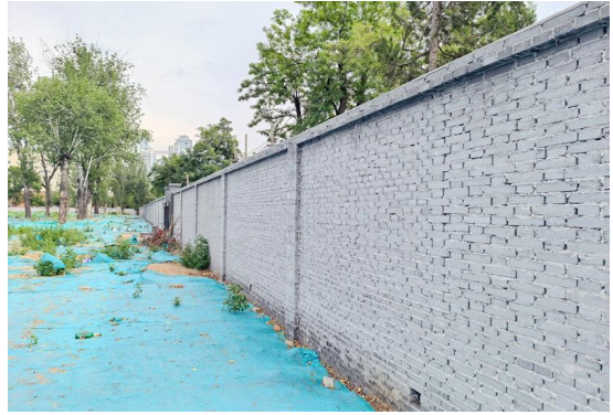
项目南侧围墙
