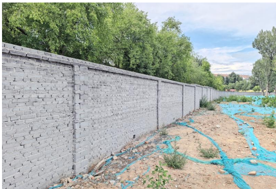
项目西侧围墙
