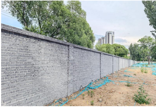
项目北侧围墙
